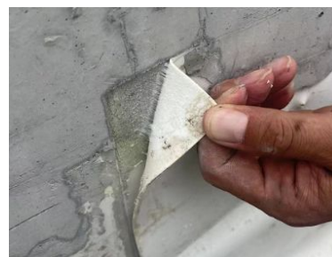
图 9 防水卷材与后浇混凝土粘接不合格
