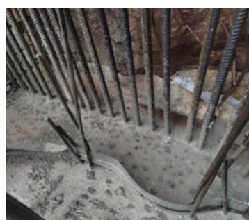
图 10 钢边橡胶止水带固定对比
