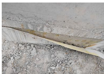
图 9 防水卷材与后浇混凝土粘接不合格
